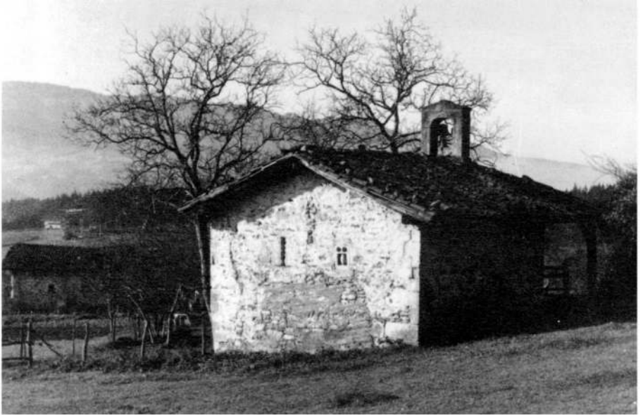
Fachada posterior y aspilleras pre-románicas.
