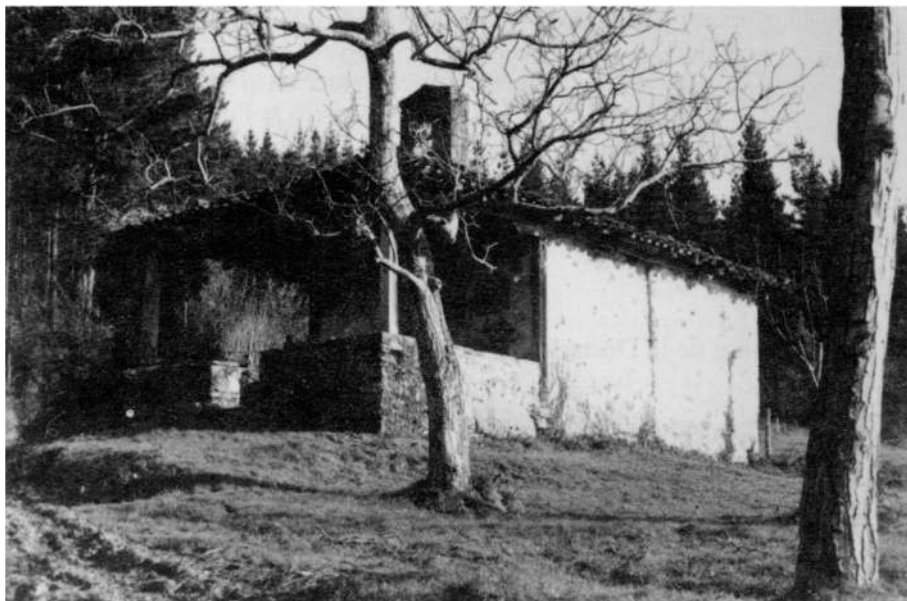
Fachada de la ermita.
